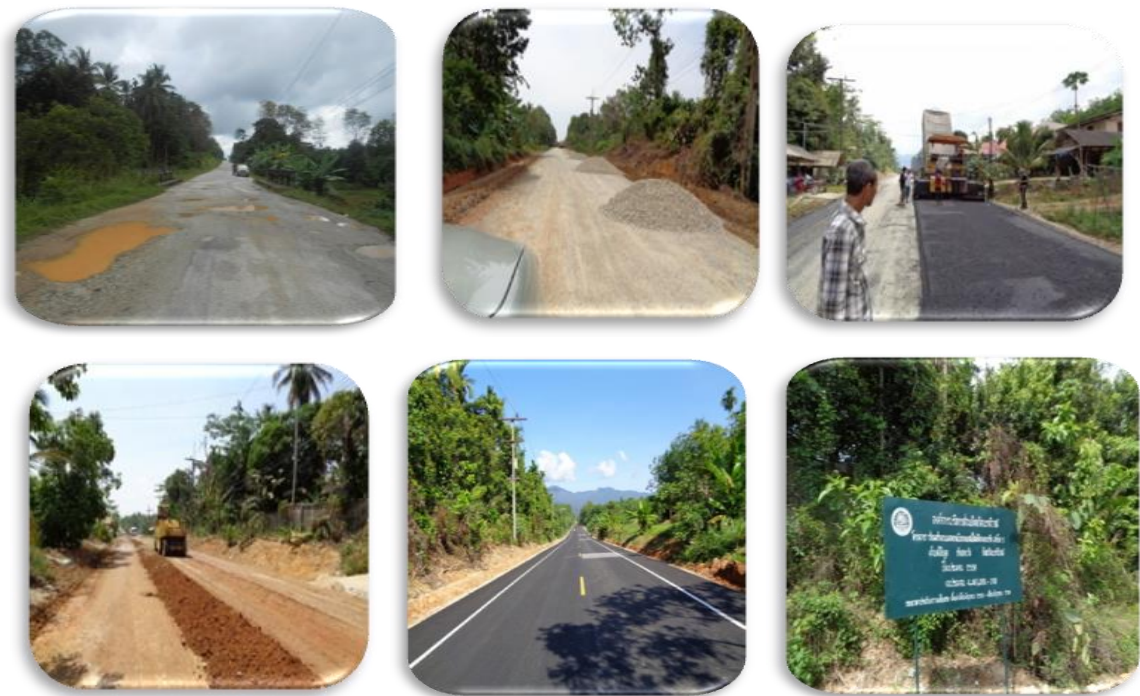
ซ่อมสร้างถนนลาดยางผิวทางแอสฟัลต์ติกคอนกรีต สายโท 3 ตำบลโละ๊ะจุด อำเภอแว้ง จังหวัดนราธิวาส
