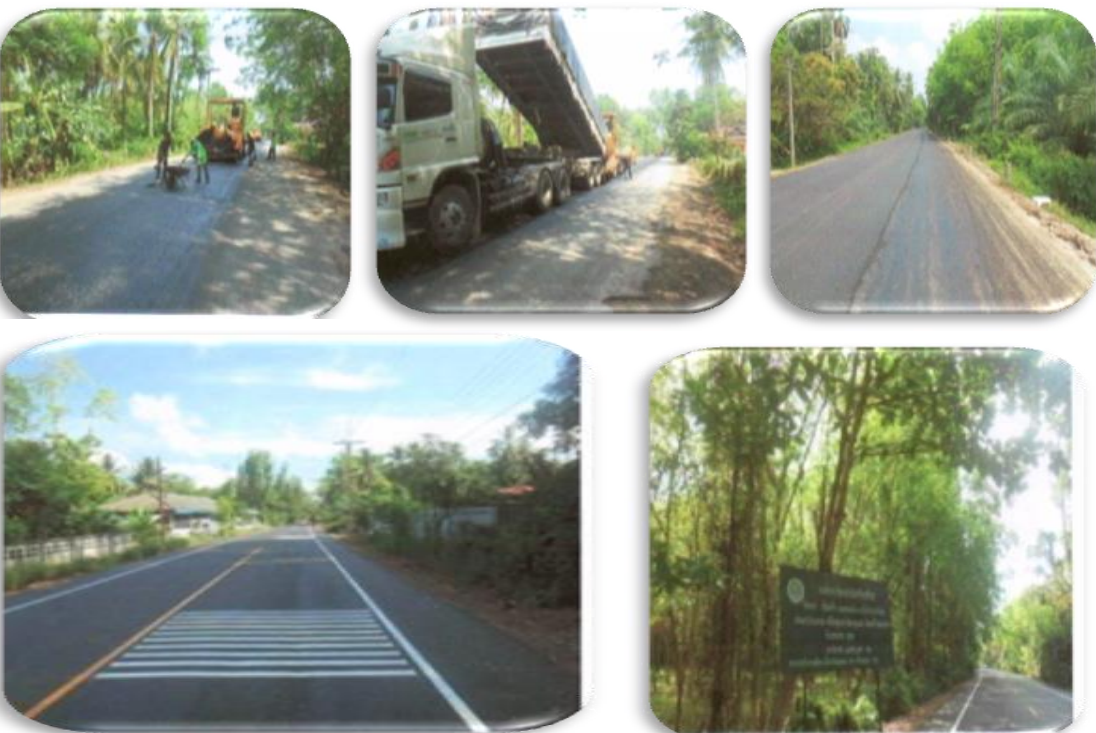
ซ่อมสร้างถนนลาดยางผิวทางแอสฟัลต์ติกคอนกรีตสายสามแยกบ้านนายดวง – บ้านโคกชุมบก ตำบลบางขุนทอง อำเภอตากใบ จังหวัดนราธิวาส
