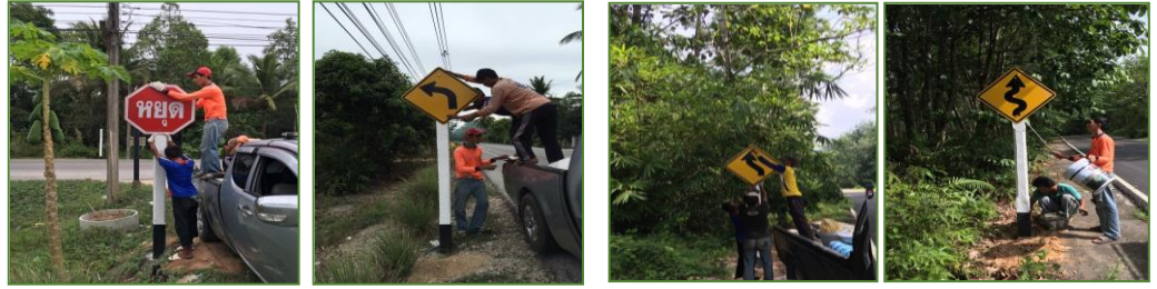
“การติดตั้งป้ายจราจรถนนในความรับผิดชอบ”
