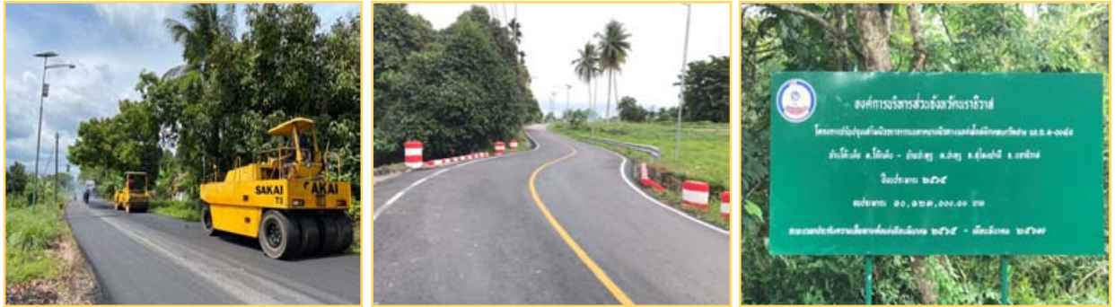
“ปรับปรุงเสริมผิวจราจรถนนลาดยางผิวทางแอสฟัลต์ติกคอนกรีต สาย นธ.ถ 1-0040 บ้านโต๊ะเต็ง ต.โต๊ะเต็ง – บ้านปะลูรู อ.สุโหงปาตี จ.นราธิวาส
